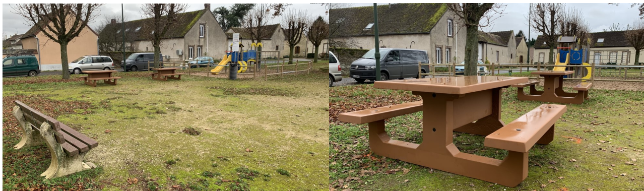
Mise en place de deux tables de pique-nique Place Lucien Pothier
